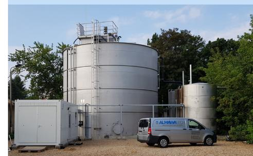
Abb. 2: Anlage zur CO<sub>2</sub>-Neutralisation und Vergleichmäßigung 1.000m<sup>3</sup>/Tag
